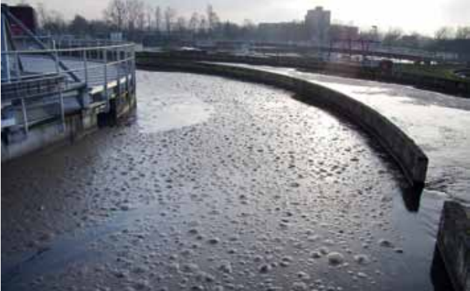
Actiefslibtank waar de biologische zuivering plaatsvindt.
