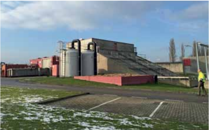
Bunker waar het afvalwater op hoogte wordt gebracht, zodat het daarna onder vrij verval door de hele installatie kan lopen.
