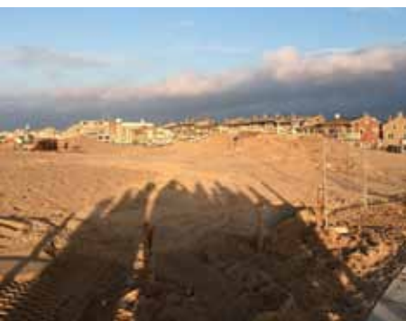
Grondverzet voor de de nieuwe waterkering langs de kustlijn.
