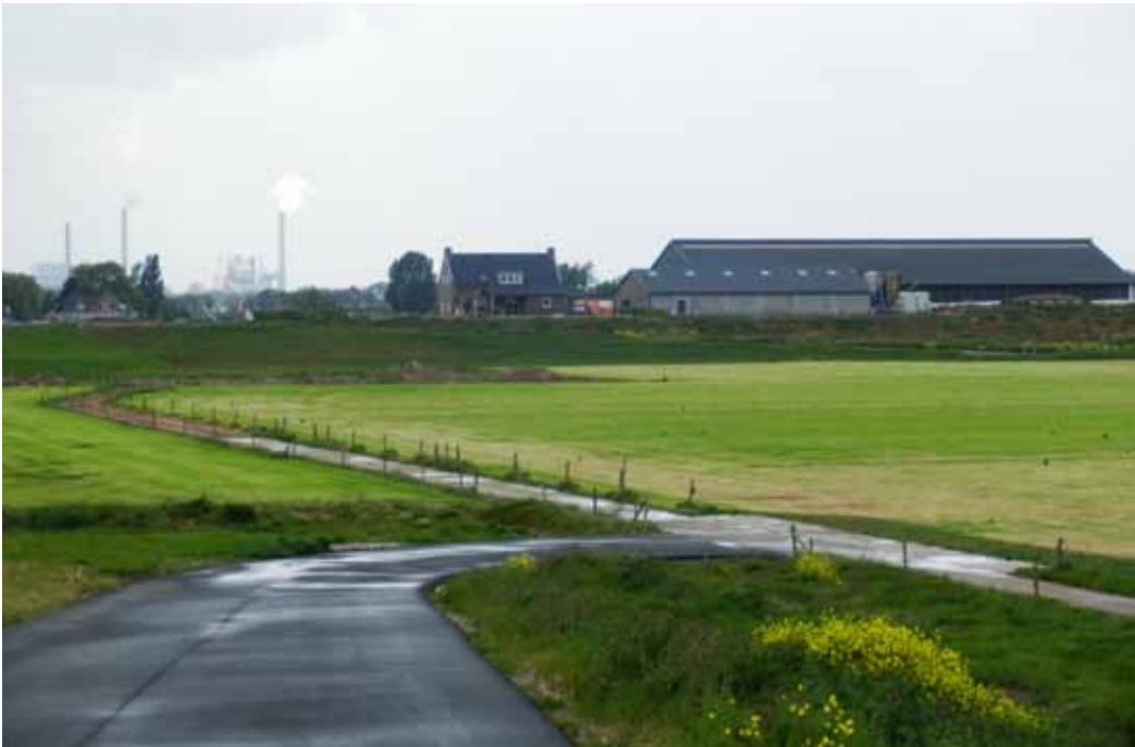
Een aantal agrariërs in de Overdiepse Polder is gebleven. Hun nieuwe boerderijen, stallen en schuren zijn op terpen gebouwd.
