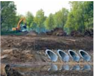
Aanleg van de 'watermachine'.
